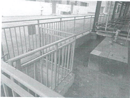
地埋溶媒罐区废液收集槽
